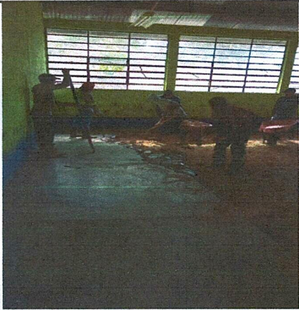
Foto 3: TRABAJOS EN PROCESO DE CAMBIOS DE PISO.
