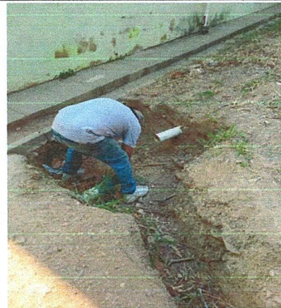
Foto 4: REPARACIÓN DE TUBERIAS EN EL ESTABLECIMIENTO.
